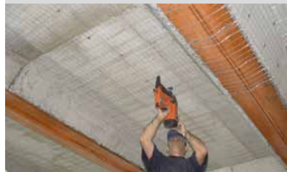
Montage des panneaux Bekaert Stucanet® sur une base en béton.
