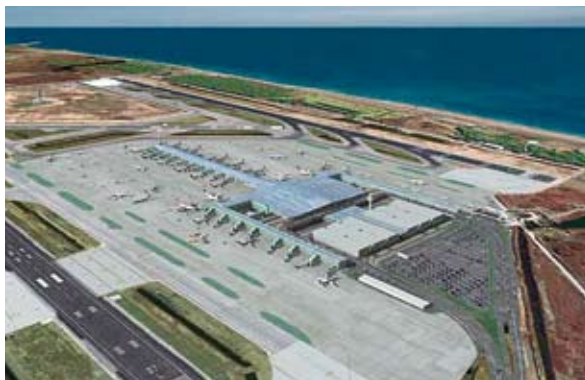
Aeropuerto Barcelona Terminal Sur, 2005-2009 (Spanje)
