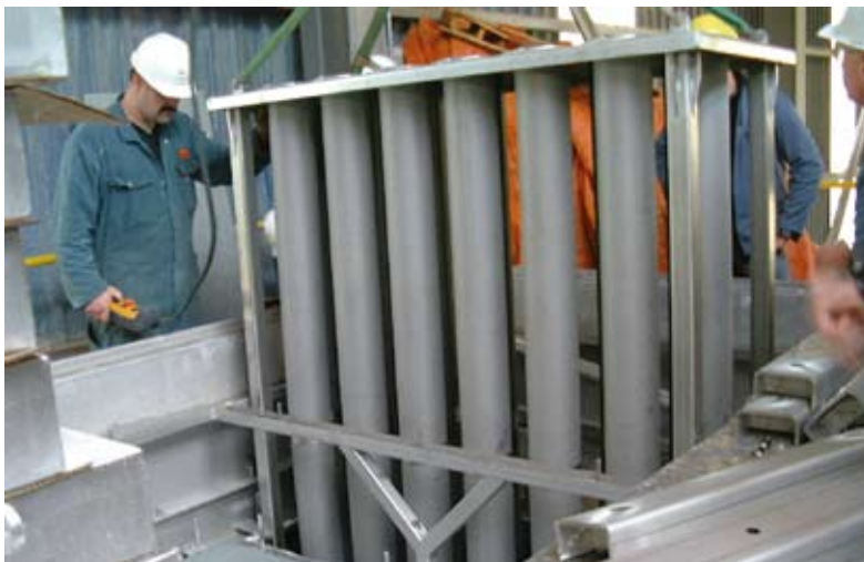
Installation des éléments filtrants
