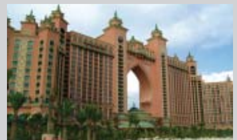
Aan de kust van Dubai beheerst Bekaert Murfor® scheurvorming in het Atlantis Hotel , gebouwd op de onstabiele bodem van het kunstmatige eiland Palm Jumeirah.
