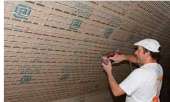
Schnelle und einfache Anbringung von Bekaert Stucanet® auf Holzsparren.
