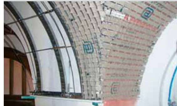
Bekaert Stucanet®-Paneele sind sehr biegsam und können einfach auf Metallprofilen angebracht werden.
