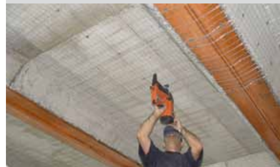
Montage von Bekaert Stucanet® auf Betonuntergrund.
