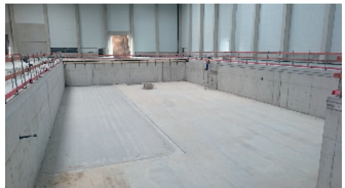
Bild 5. Fertiger Industrieboden im Grubenbereich
