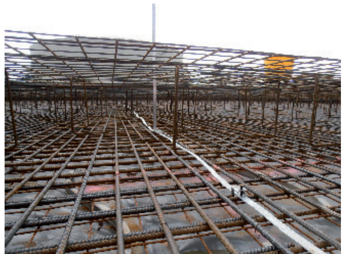
Bild 1. Bewehrungsführung in der Bodenplatte
