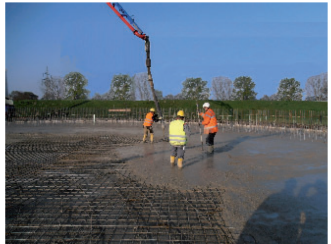
Bild 3. Betoniervorgang bei entspannter Bewehrungsführung
