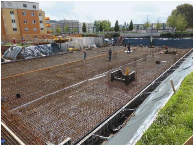
**Bild 9.** Bewehrungsführung in der Bodenplatte der Wohnhäuser
