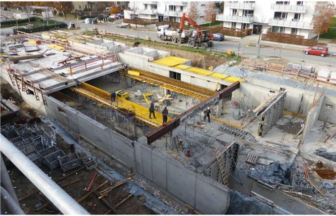
**Bild 6.** Schal- und Bewehrungsarbeiten im Bereich der Tiefgarage am Übergang zum Wohnhaus 1
