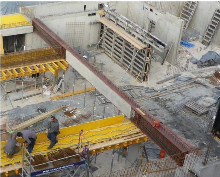
**Bild 8.** Stahlverbundträger unterhalb der Außenwand vom Wohnhaus 1
