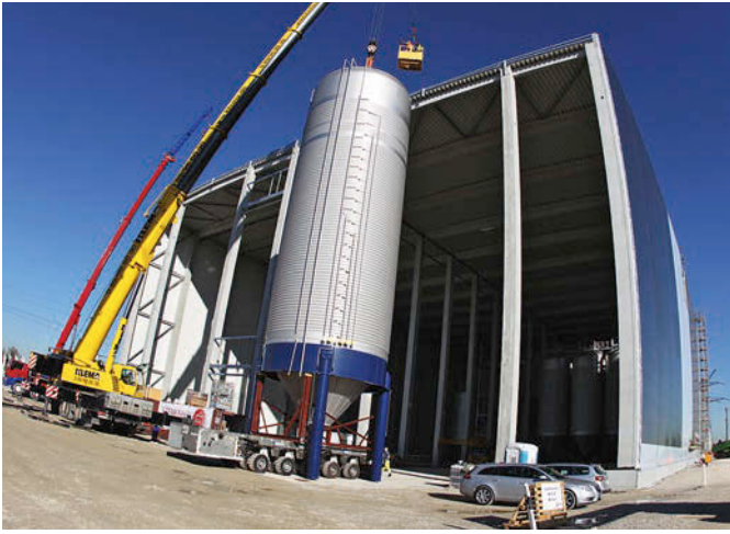
Bild 2. Gebäude K10 bei der Tankmontage
