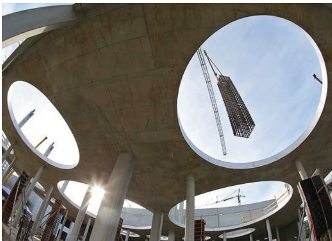
Bild 5. Sudhaus-Zwischendecke real vor der Sudkesselmontage
