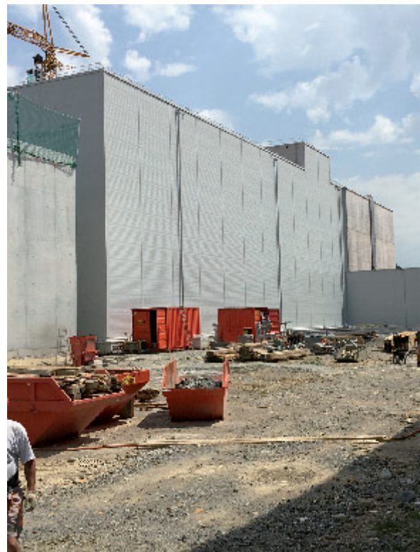
Bild 2. Hochregallager bei bereits geschlossener Gebäudehülle
