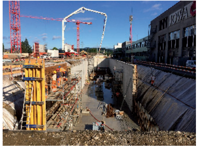
Bild 4. Betoneinbau mittels Betonpumpe
