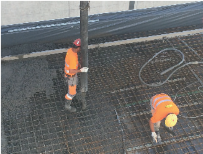
Bild 3. Entspannte Bewehrungsführung
