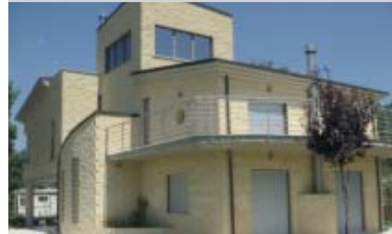
Abitazione dell'Ing. Salvatori a l'Aquila (Italia)
